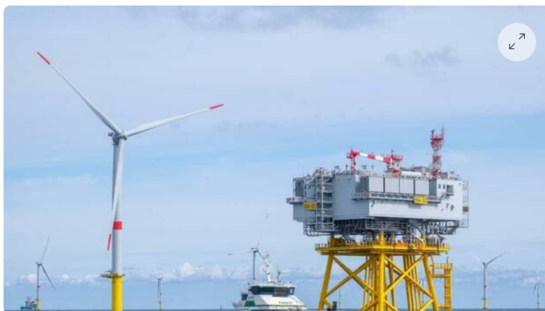
La sous-station électrique, sorte de gros transformateur construit par les Chantiers de l'Atlantique, est installée au beau milieu d'un champ de 80 éoliennes espacées chacune d'1 km | PRESSE Océan-SIMON TORLOTIN
